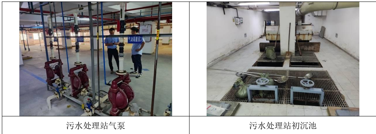
图 5-2 水污染防治措施图片
