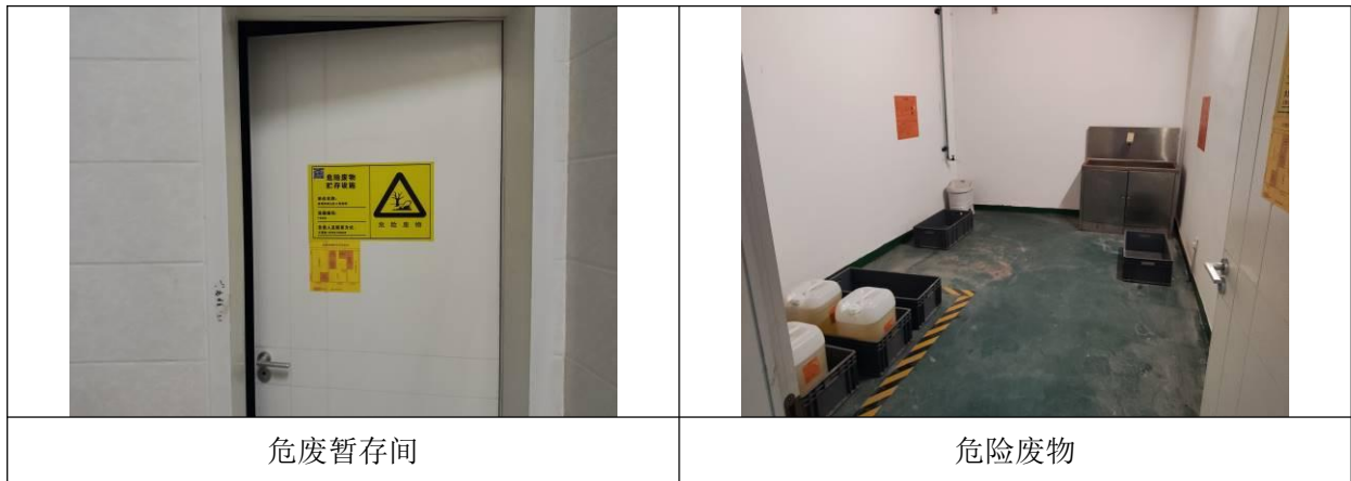
图 5-13 危险废物暂存设施
